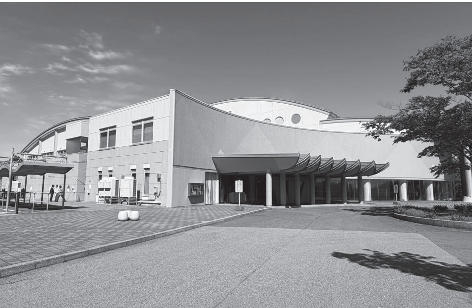
「ココBOX II」が設置されている佐渡中央文化会館（アミューズメント佐渡）
